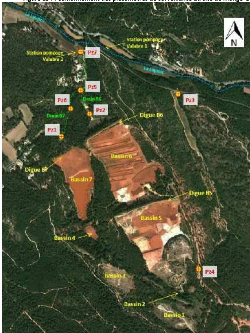
Figure 15 : Positionnement des piézomètres de surveillance du site de Mange-Garri
